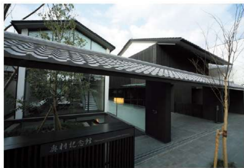
奈良県奈良市にある奥村記念館。得意技術の「免震」を採用しており、実物の免震装置の設置状況も見学できる
