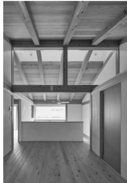
2階フリースペース。越屋根から光を採り込み熱気を排出する。欄間は熱溜まりをつくるために不要とする
