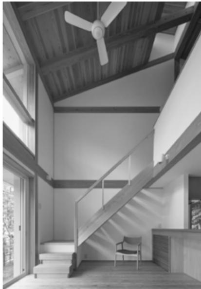
階段室を吹抜けに配置。右下に見える格子のなかに、床置きエアコンを沈めている
